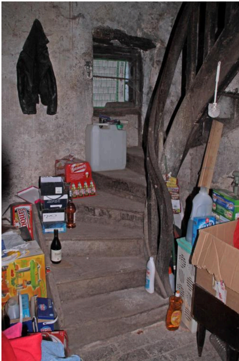
Buanderie : escalier remanié fin XVIIIe siècle et passant devant la fenêtre.
