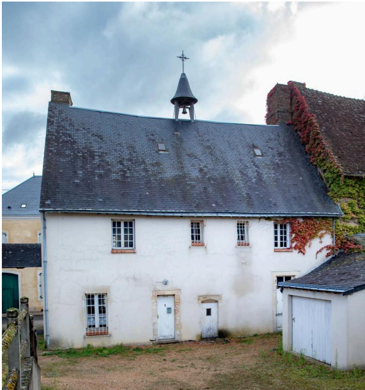
Le bâtiment principal côté cour.
