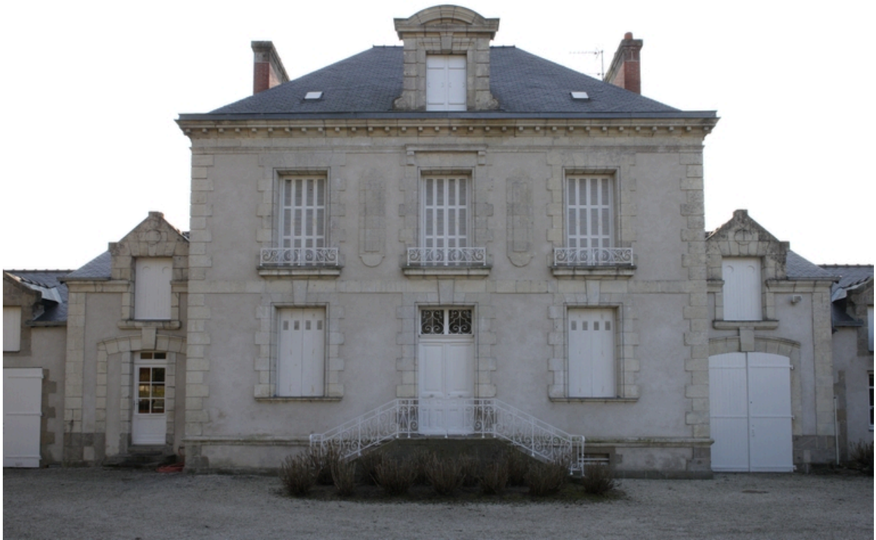
Vue de la façade nord.
