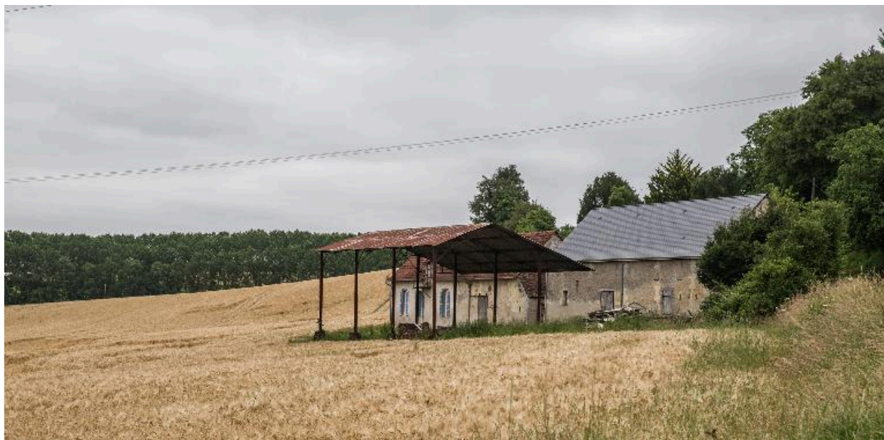
Hangar à structures métalliques et ferme précédente.
