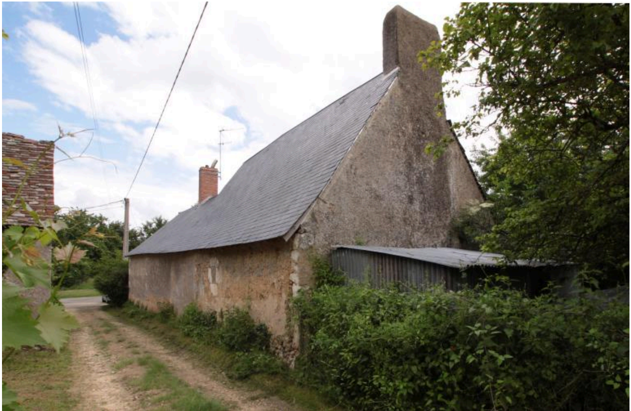
Vue de volume avec mur-pignon ouest de la maison n° 6.
