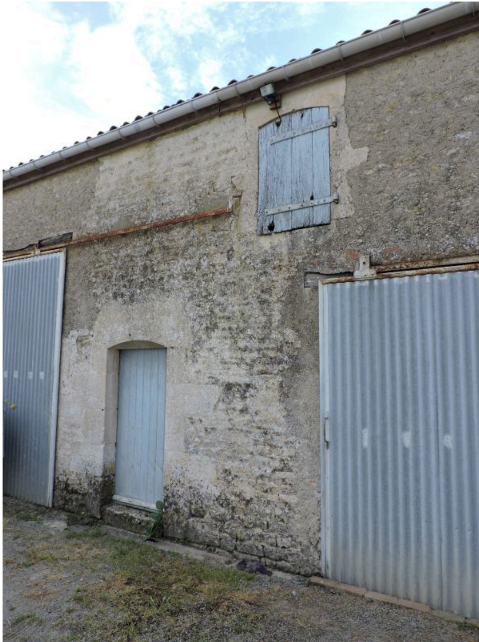
Ouvertures de l'ancien logement, avec linteaux en arc délardé ou segmentaire.
