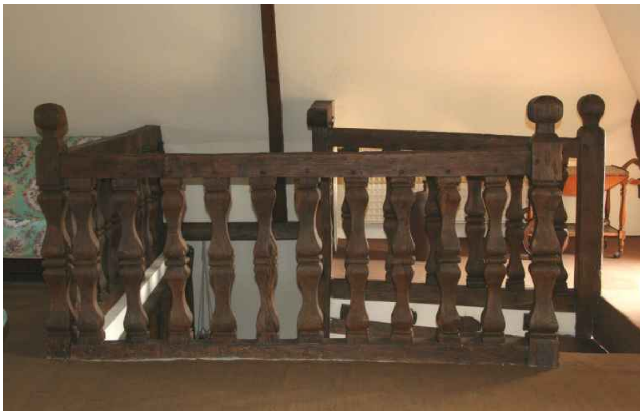
Palier du comble.
