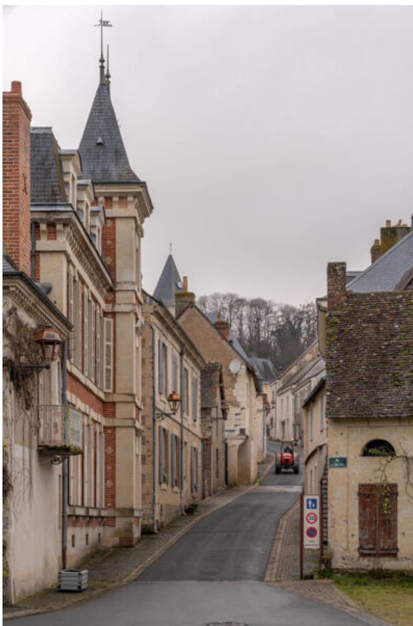
La rue du Collège, vue depuis l'est.
