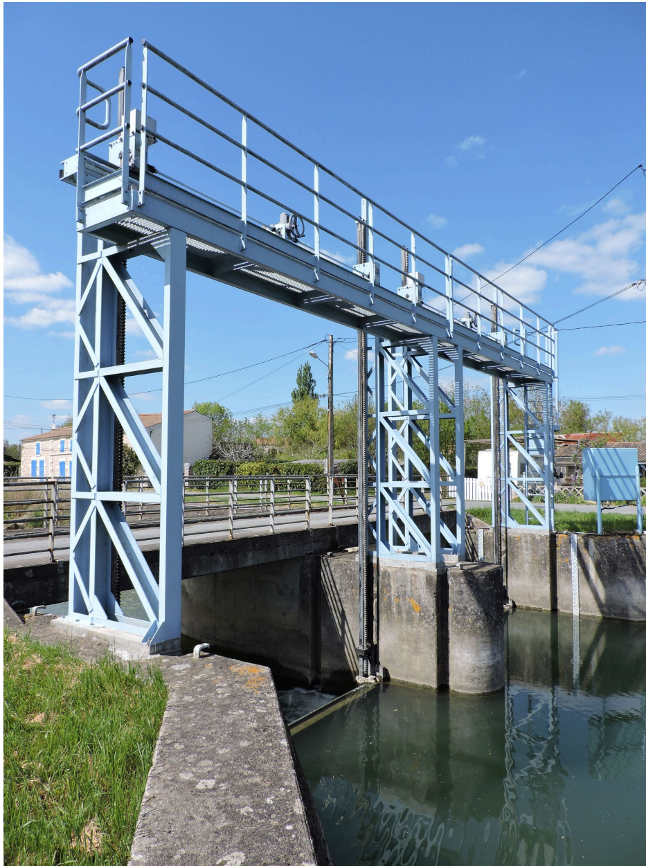
Le portique soutenant les vannes.
