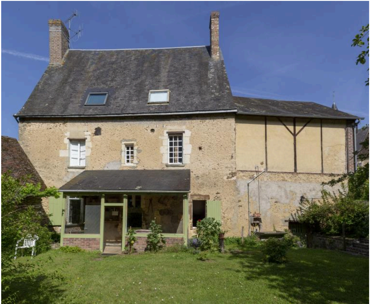
La façade postérieure.
