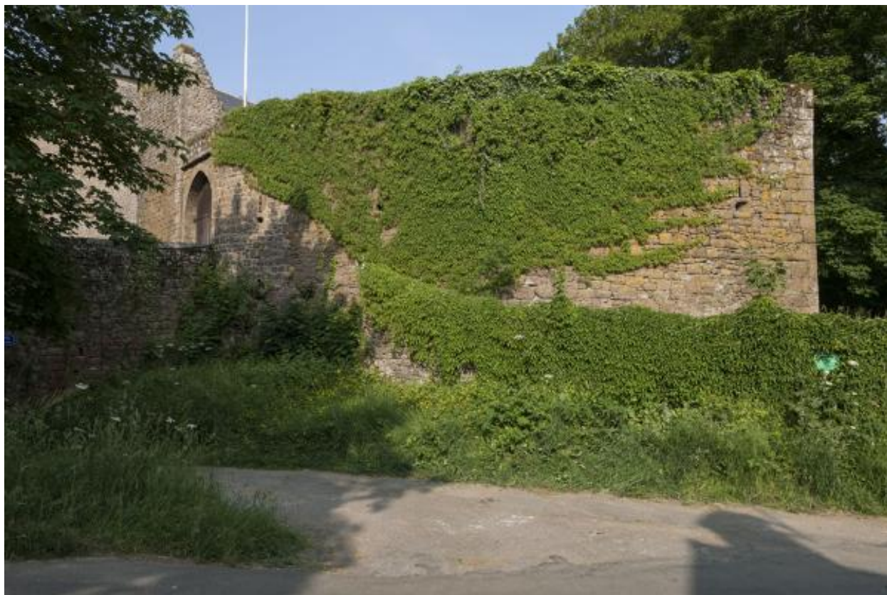
Boulevard d'artillerie, depuis l'est.
