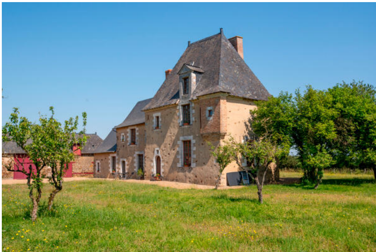
Le corps de logis, élévation principale.
