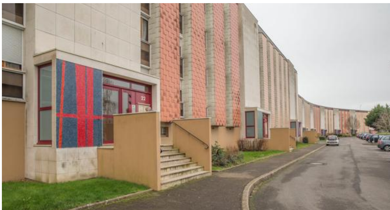
Vue de la barre rue du Mont Pelvoux depuis l'est.
