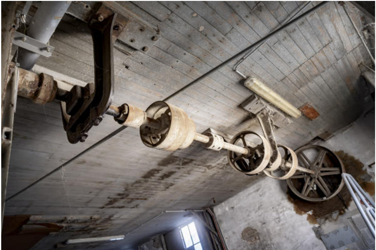
Vestige du système de transmission de l'atelier de couchage B.
