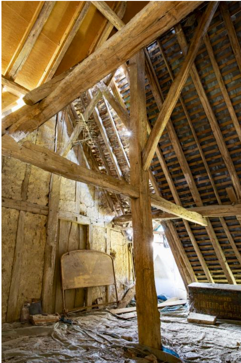
La charpente du logement le plus ancien.
