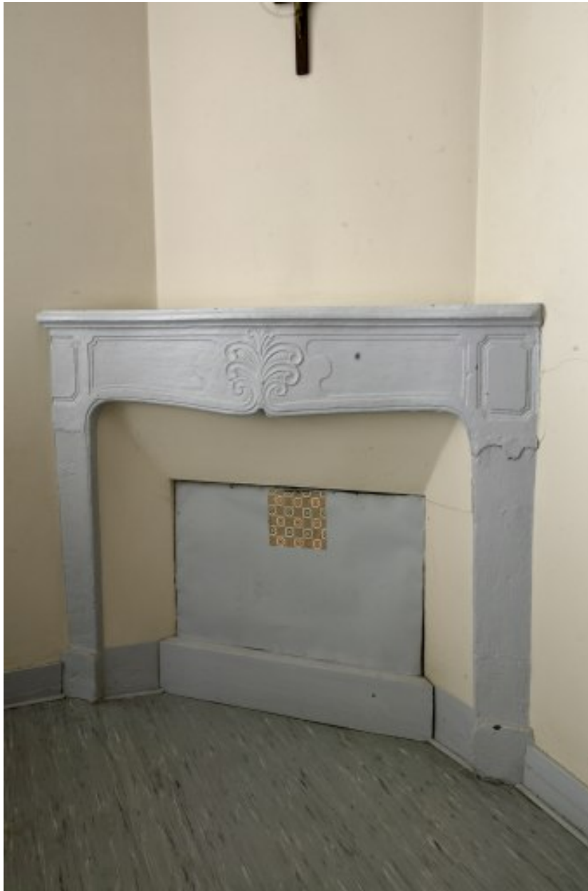
Cheminée de l'une des pièces du premier étage.
