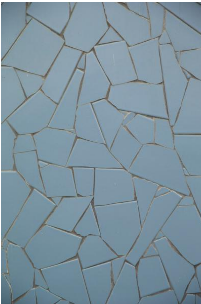
Détail de parement céramique bleue en façade d'un immeuble rue Edouard Henriot.
