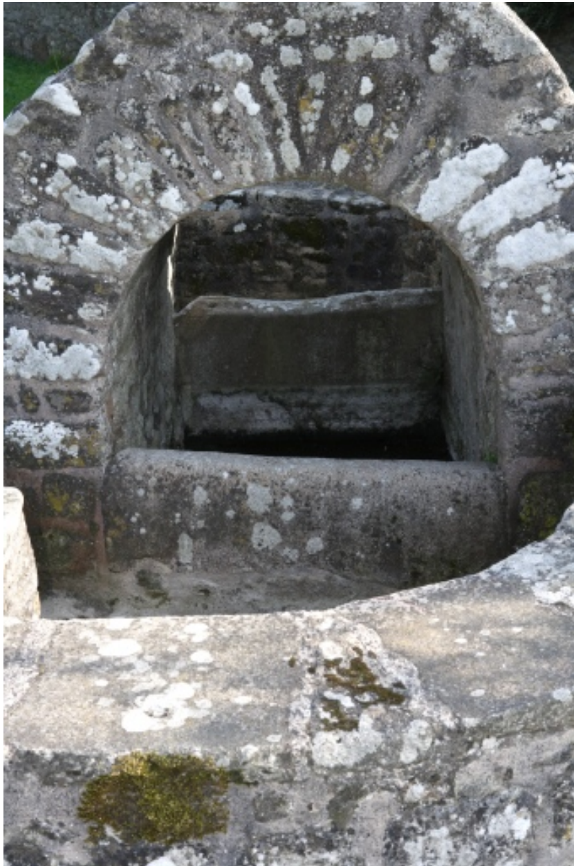
Détail de la voûte en berceau.
