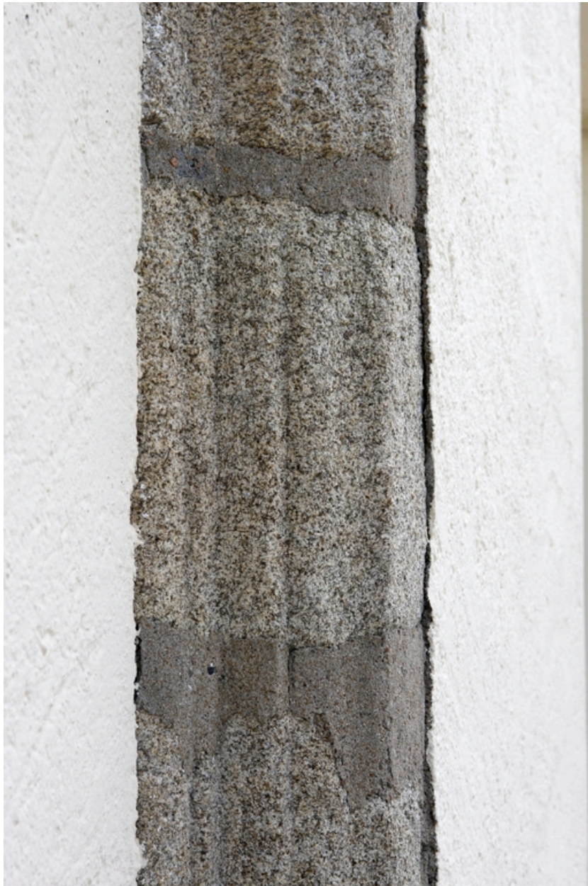
Logis. Partie ouest. Façade sud. Détail de la mouluration du piédroit de droite.
