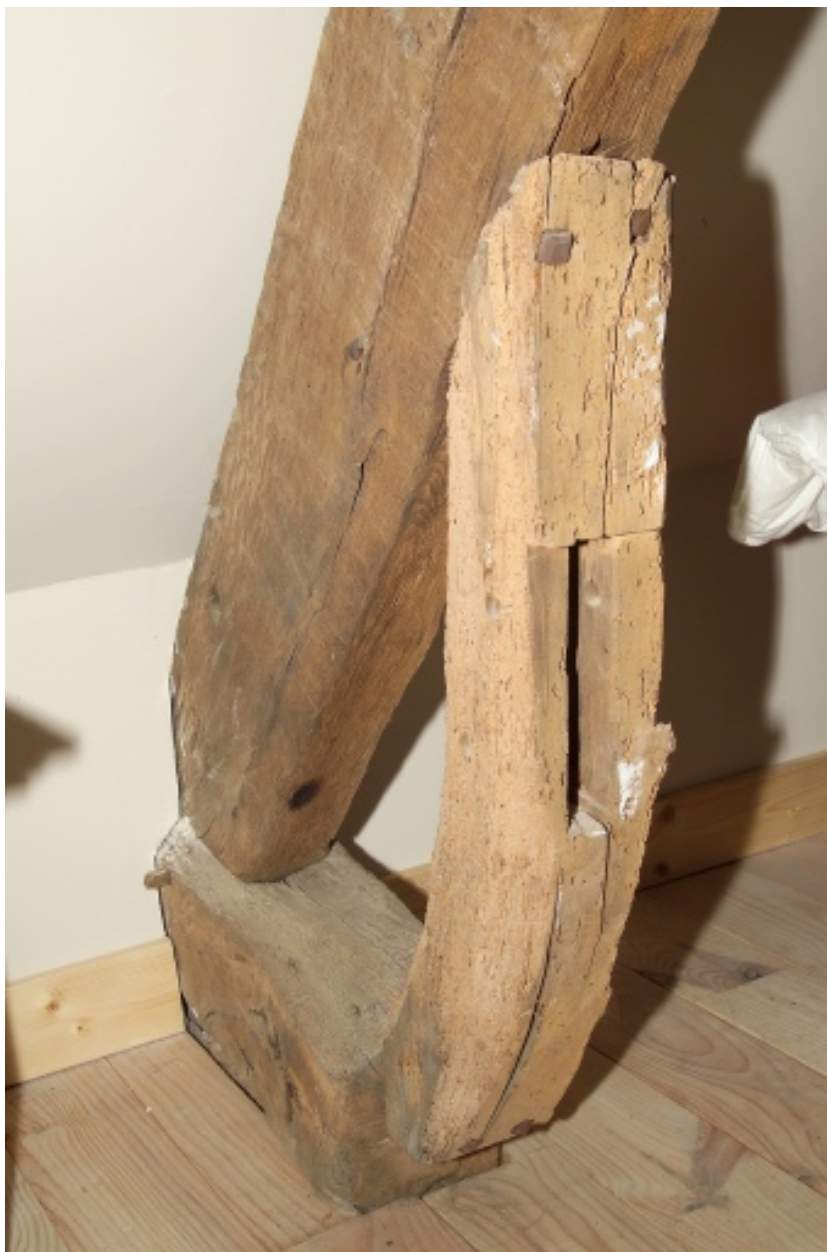
Corps sud, détail de charpente.
