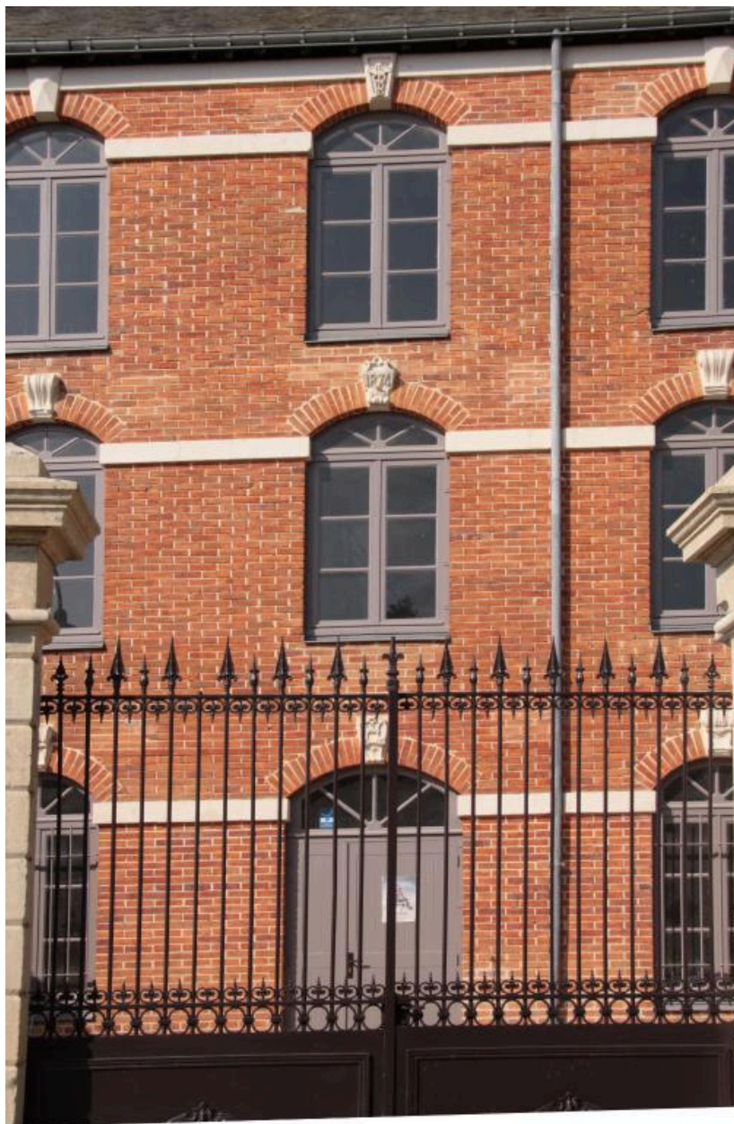
Façade sur rue : détail de la travée 4 (entrée).
