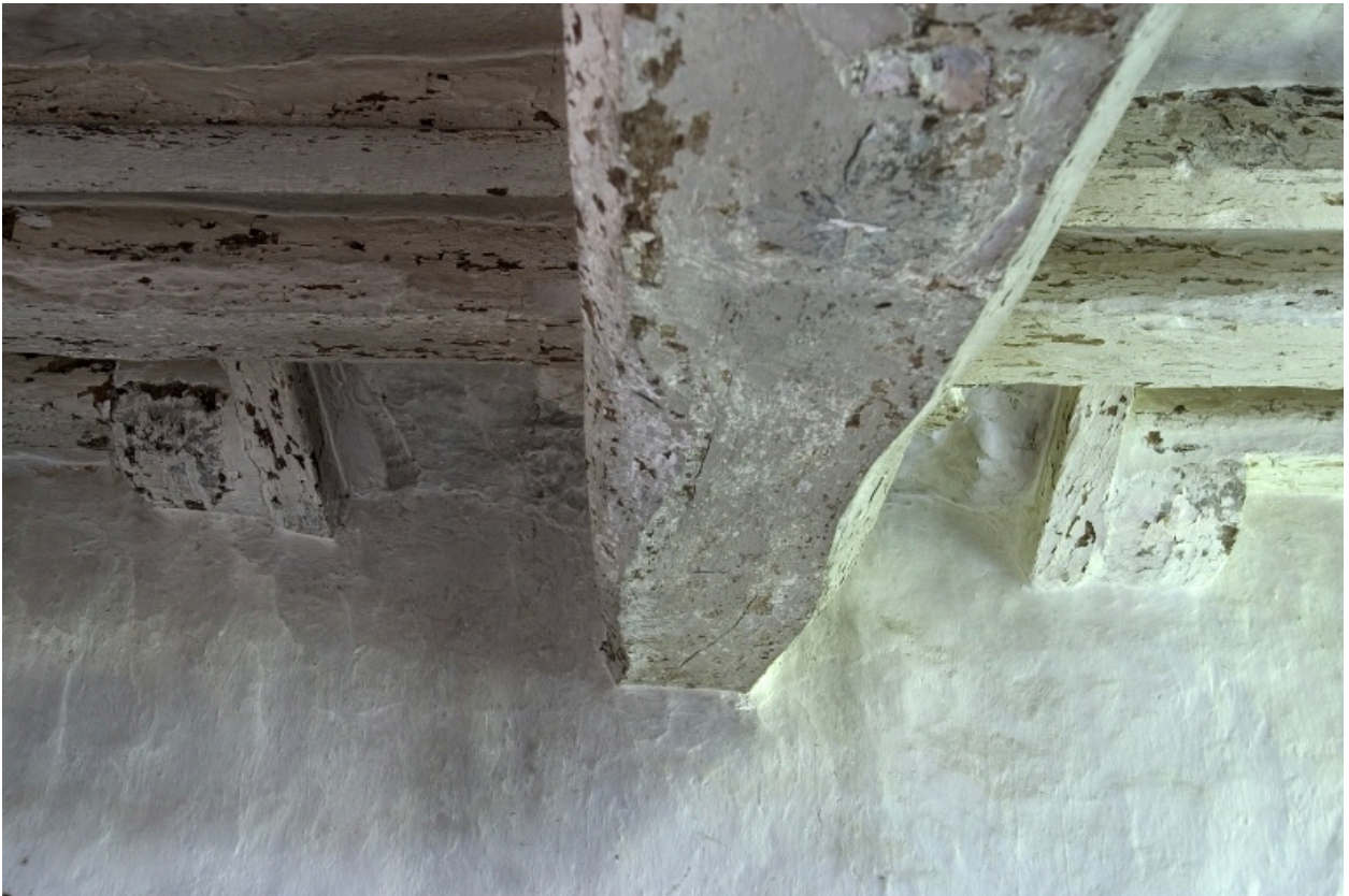
Intérieur du corps nord, grande pièce du rez-de-chaussée : vue de détail de la poutre longitudinale et des corbeaux de la cloison ouest.
