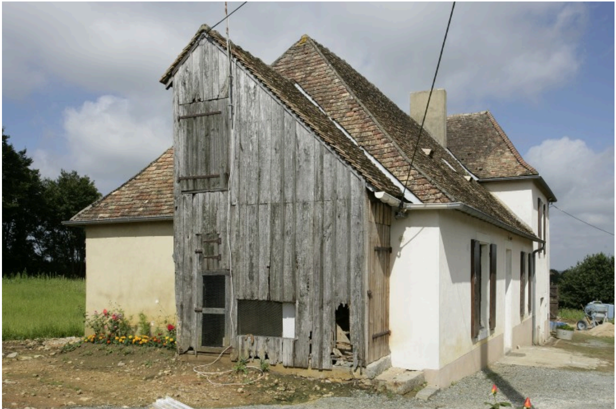
Logis, mur pignon sud : escalier d'accès au comble.
