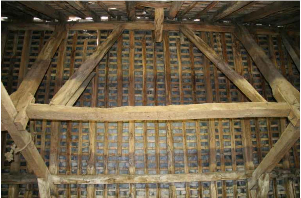
Charpente à pannes et sous-faitière remaniée en charpente de comble à surcroît.
