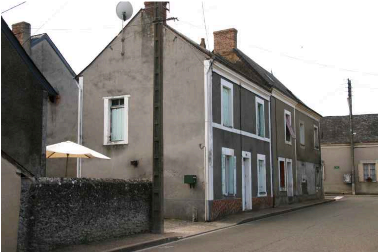
Rue des Mimosas : maison à étage entre es rues Altéa et Gratte-Poule.
