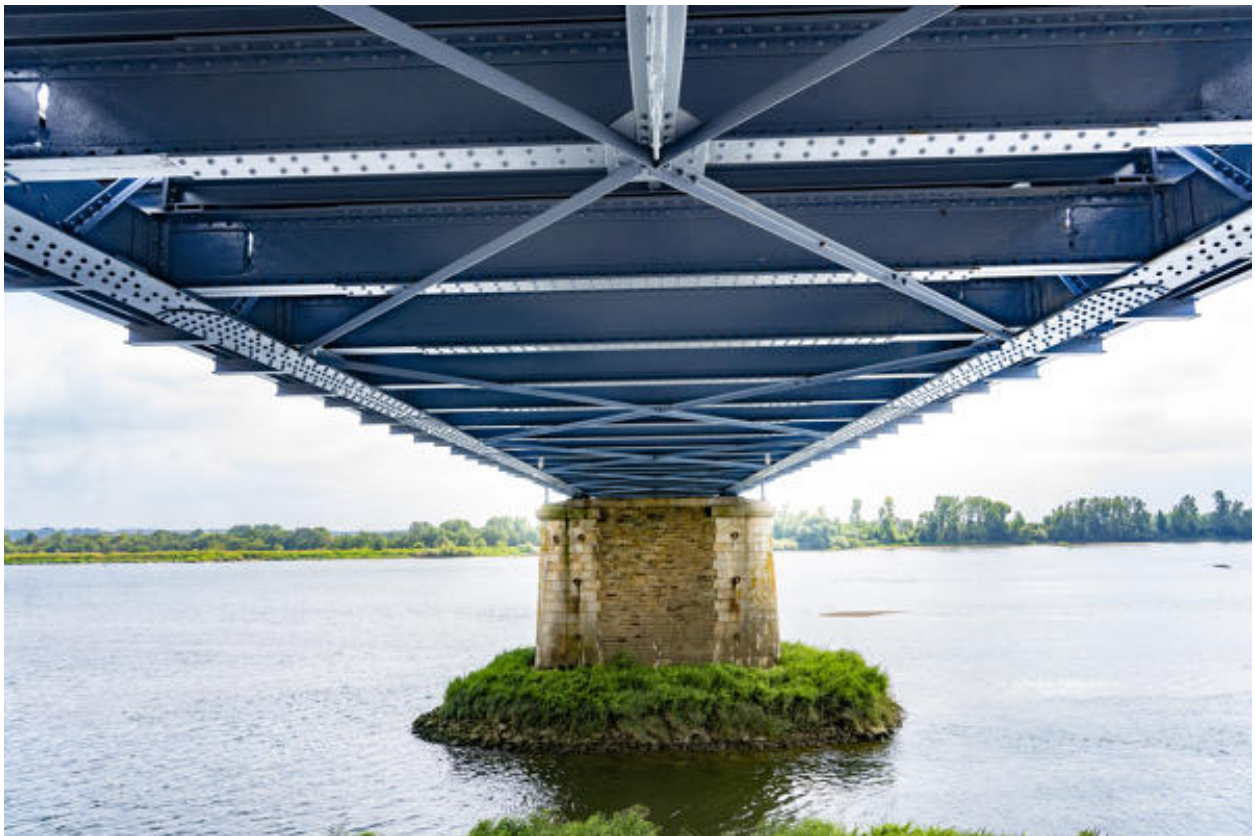
Vue de détail de la charpente métallique soutenant le tablier.
