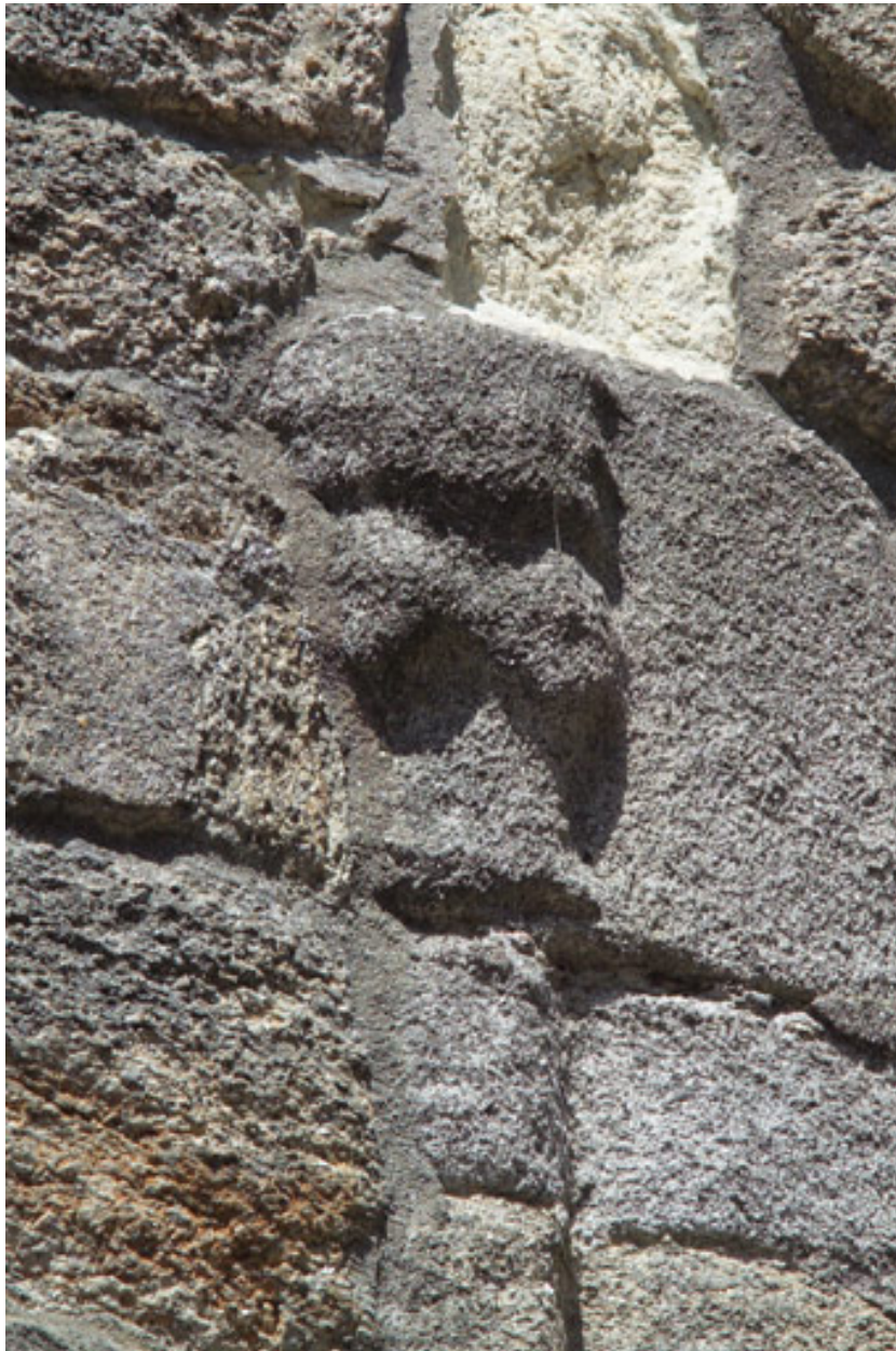
Mur sud, détail colonnette.
