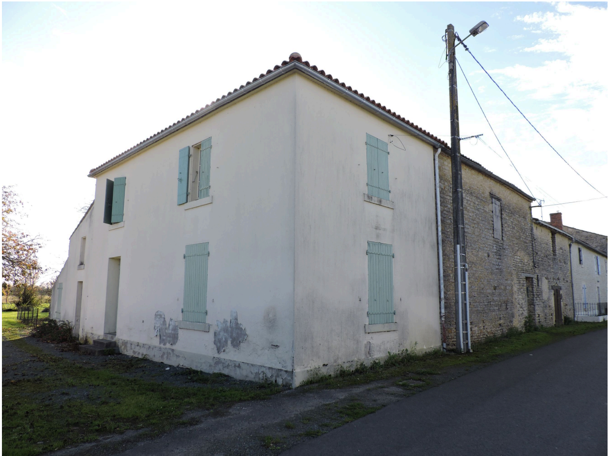
Le logis et ses dépendances vus depuis le nord-est.
