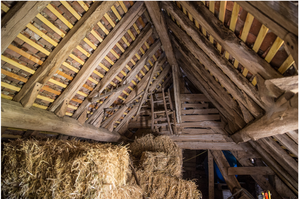
La charpente du corps de dépendances.
