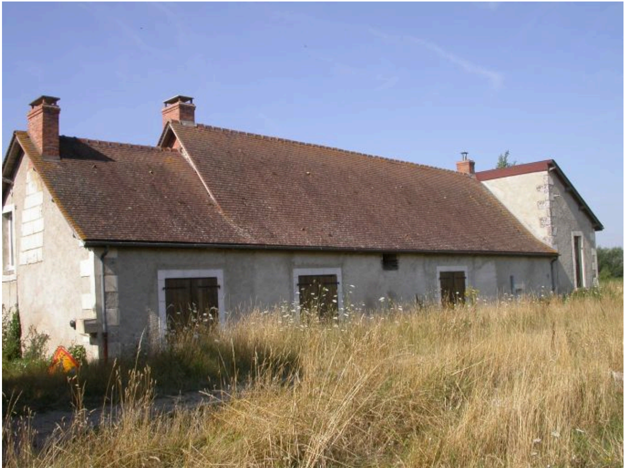
Maison d'habitation : face nord.
