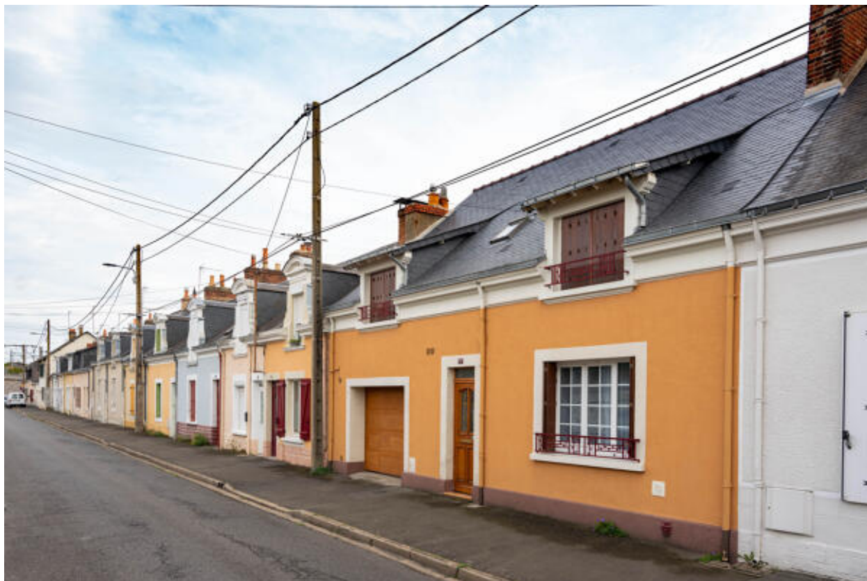
Vue d'un alignement avec mancelles rue Alfred-de-Musset.
