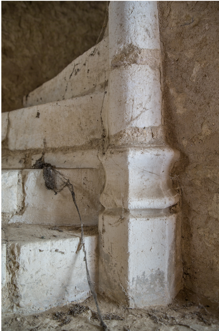
La base de l'escalier d'accès au clocher.
