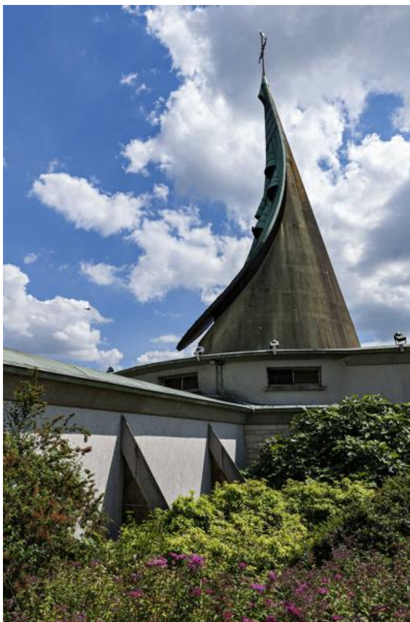
Vue latérale de la flèche de l'église.
