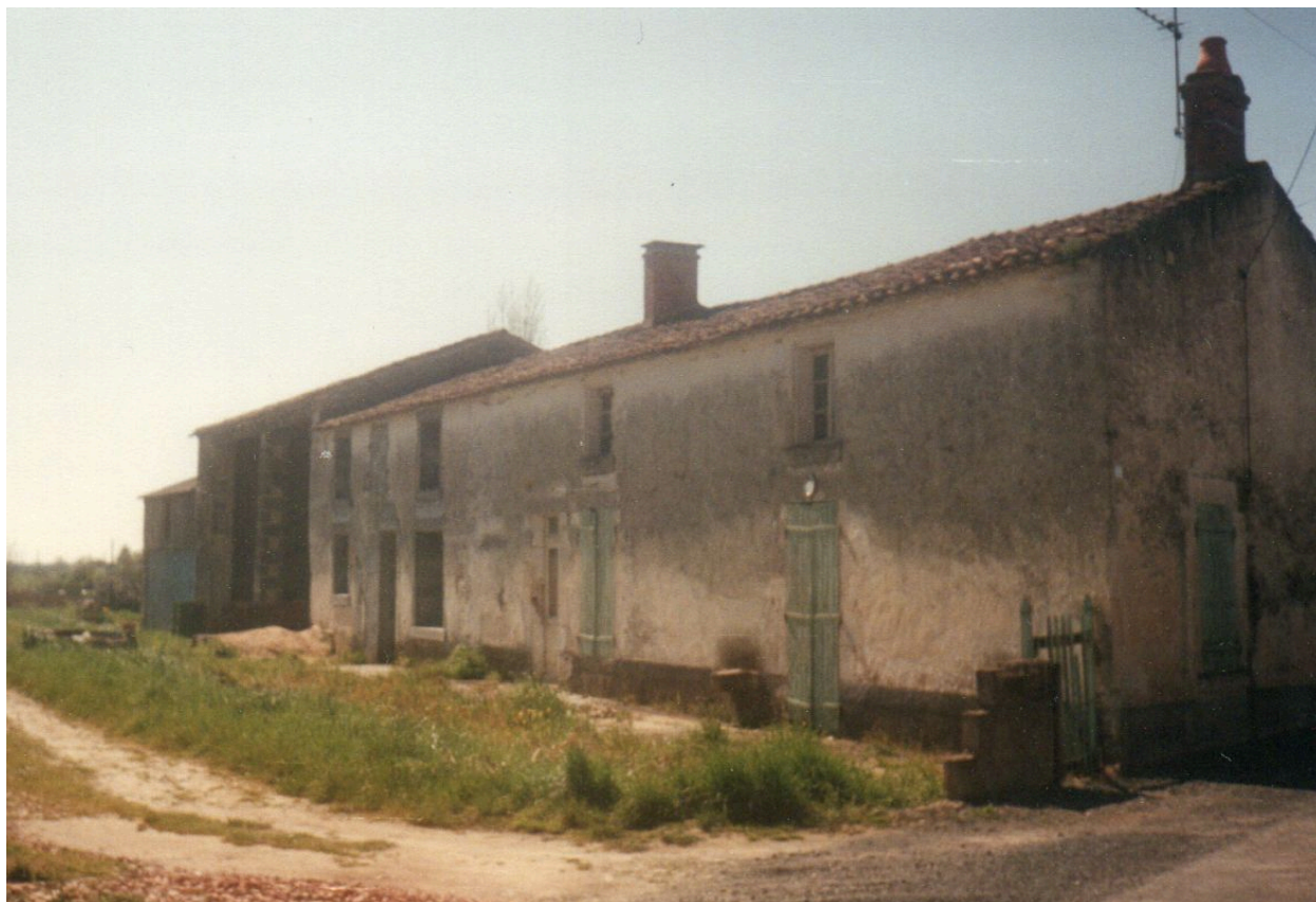
L'ancienne ferme vue depuis l'est en 1995.
