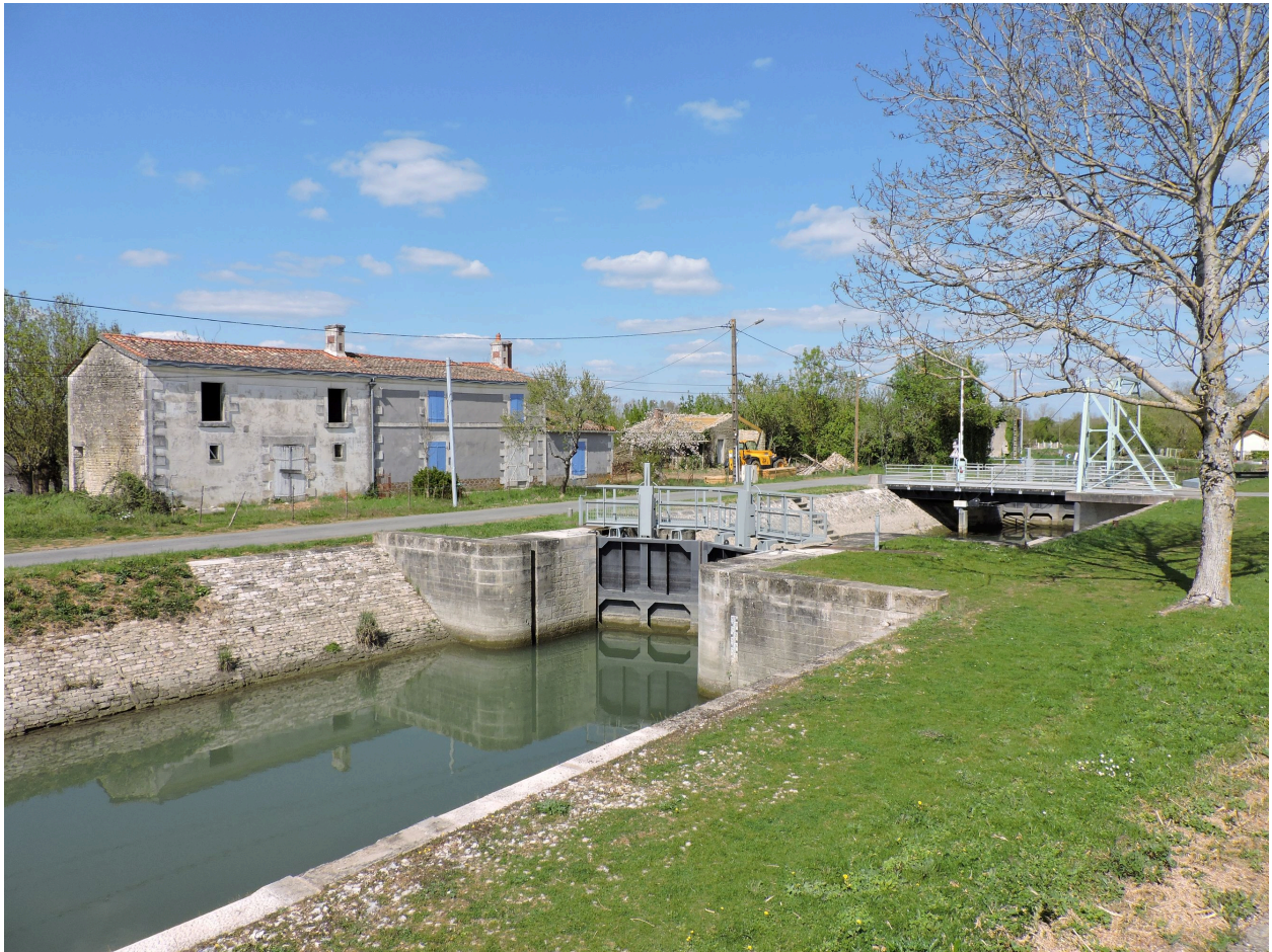
L'écluse vue depuis le sud.
