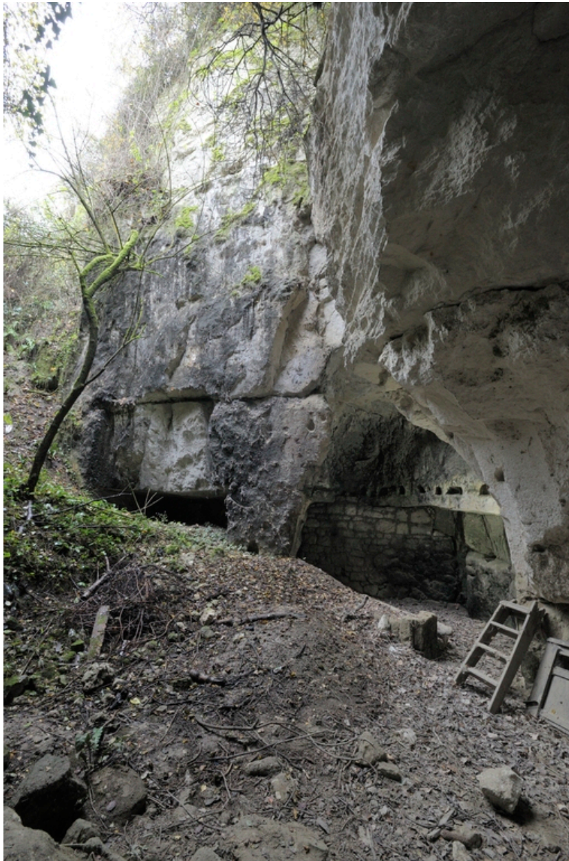
Fontis en partie postérieure de l'abri troglodytique. Anciennes dépendances agricoles (3).
