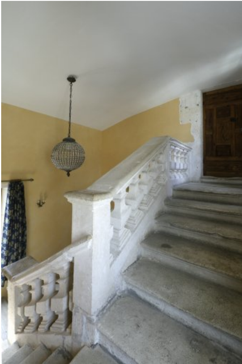
Dernière volée de l'escalier.
