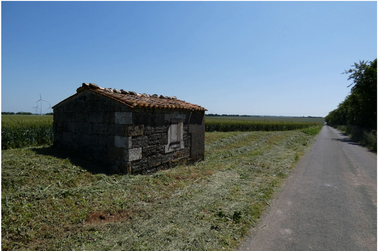
Vue depuis l'ouest.
