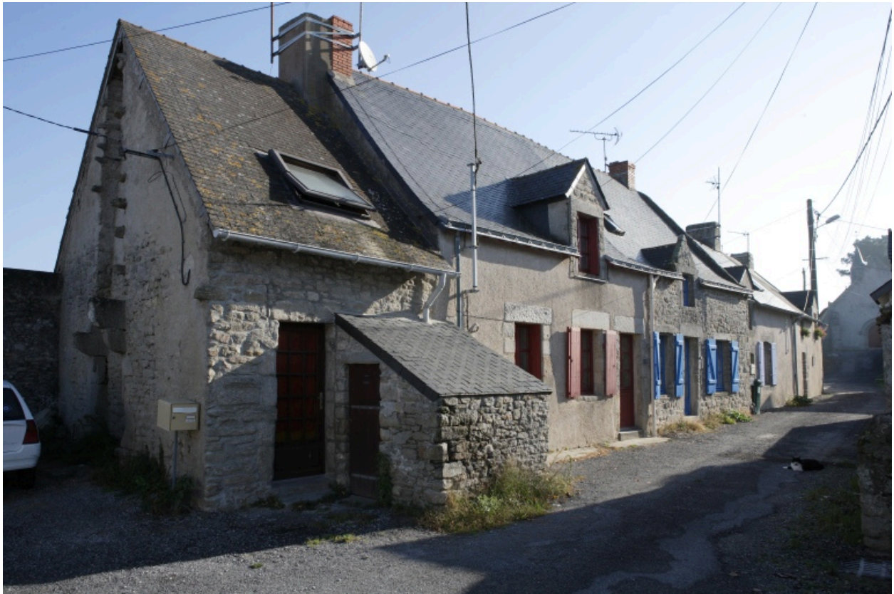
Vue de la rangée depuis l'ouest.
