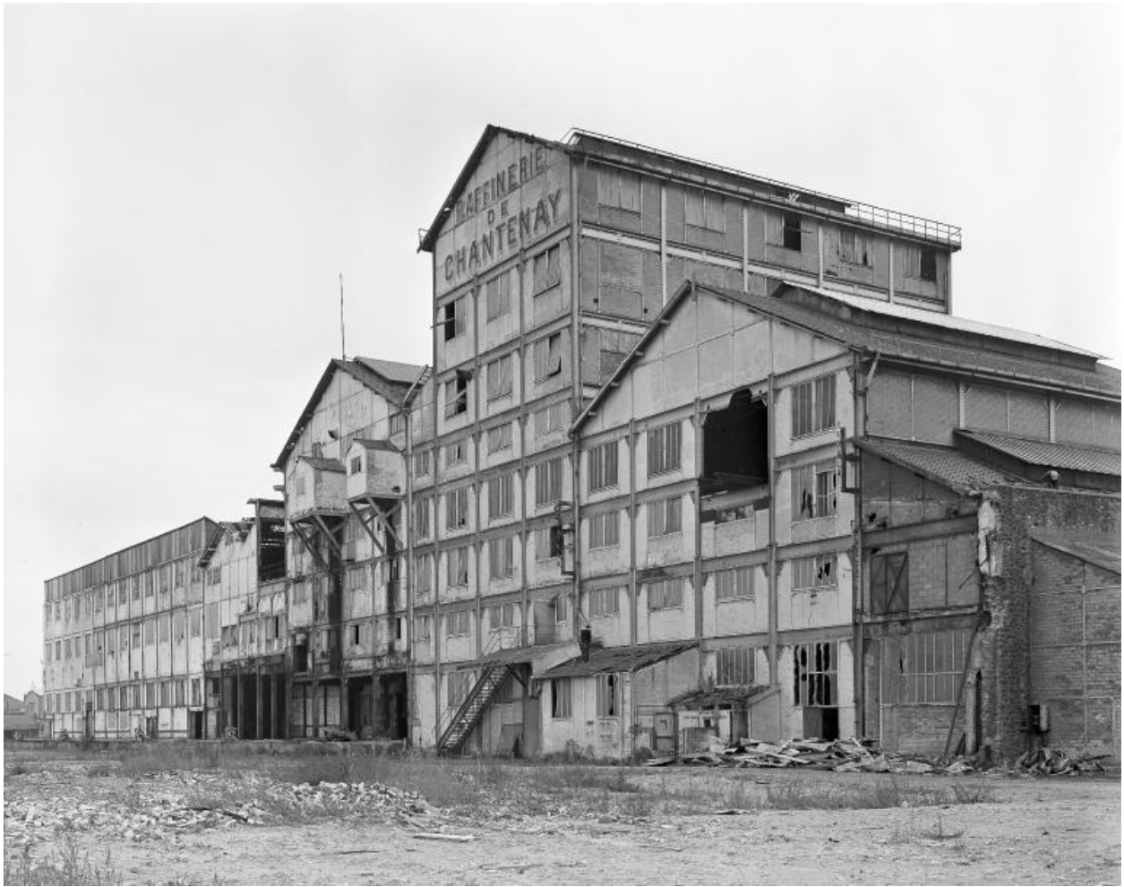
Nouvelle usine. Façades nord vues du nord-ouest.
