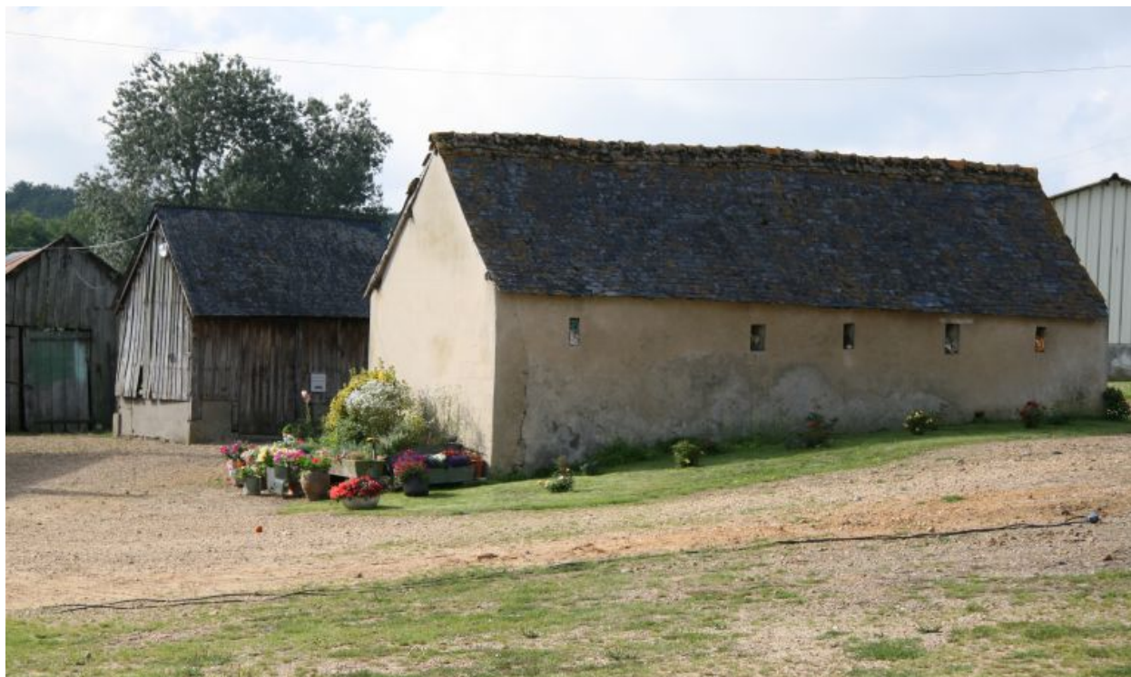
Toit à porcs qui tournent le dos à la cour.
