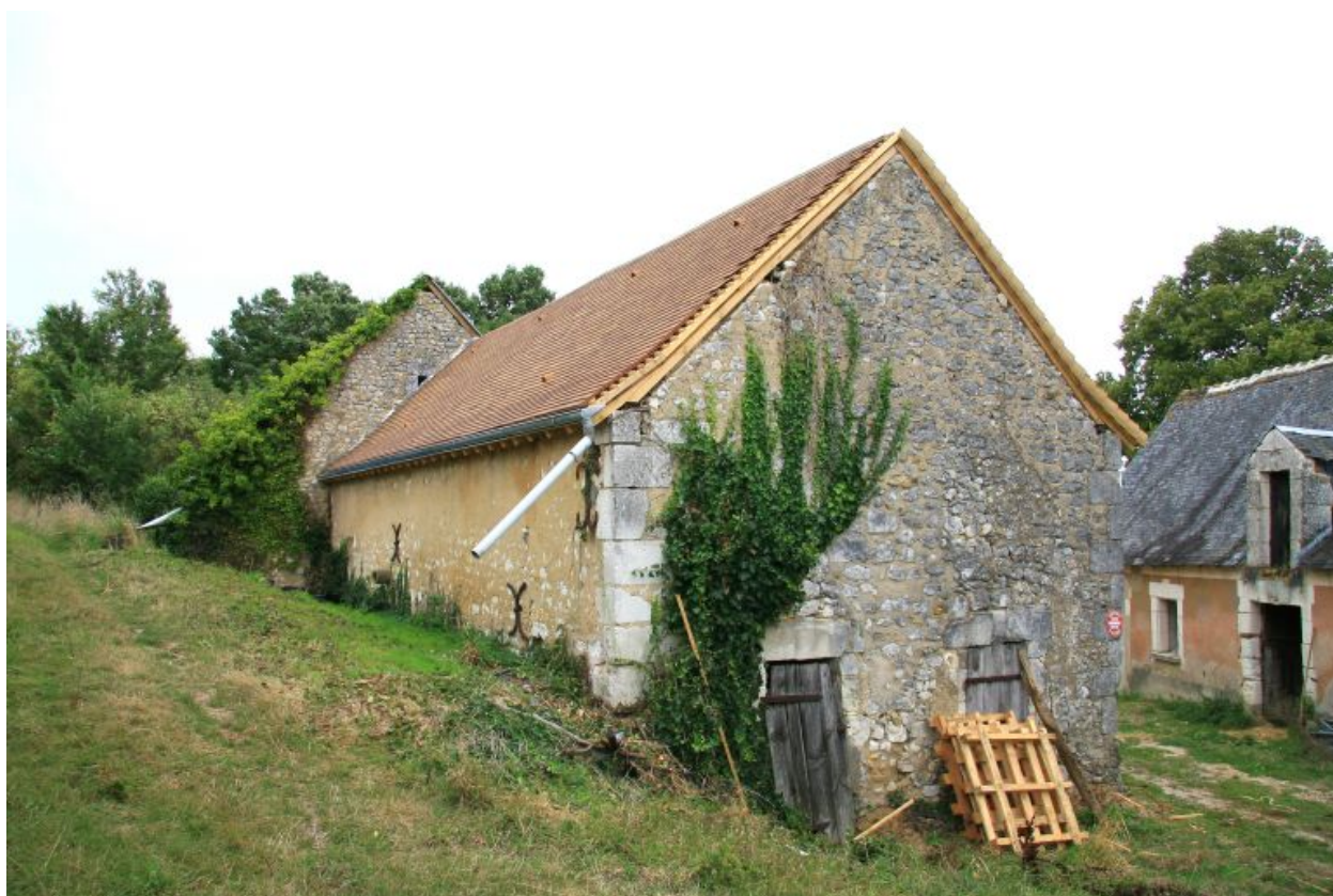
Parcelle 465 : les nouvelles étables, vue de volume.
