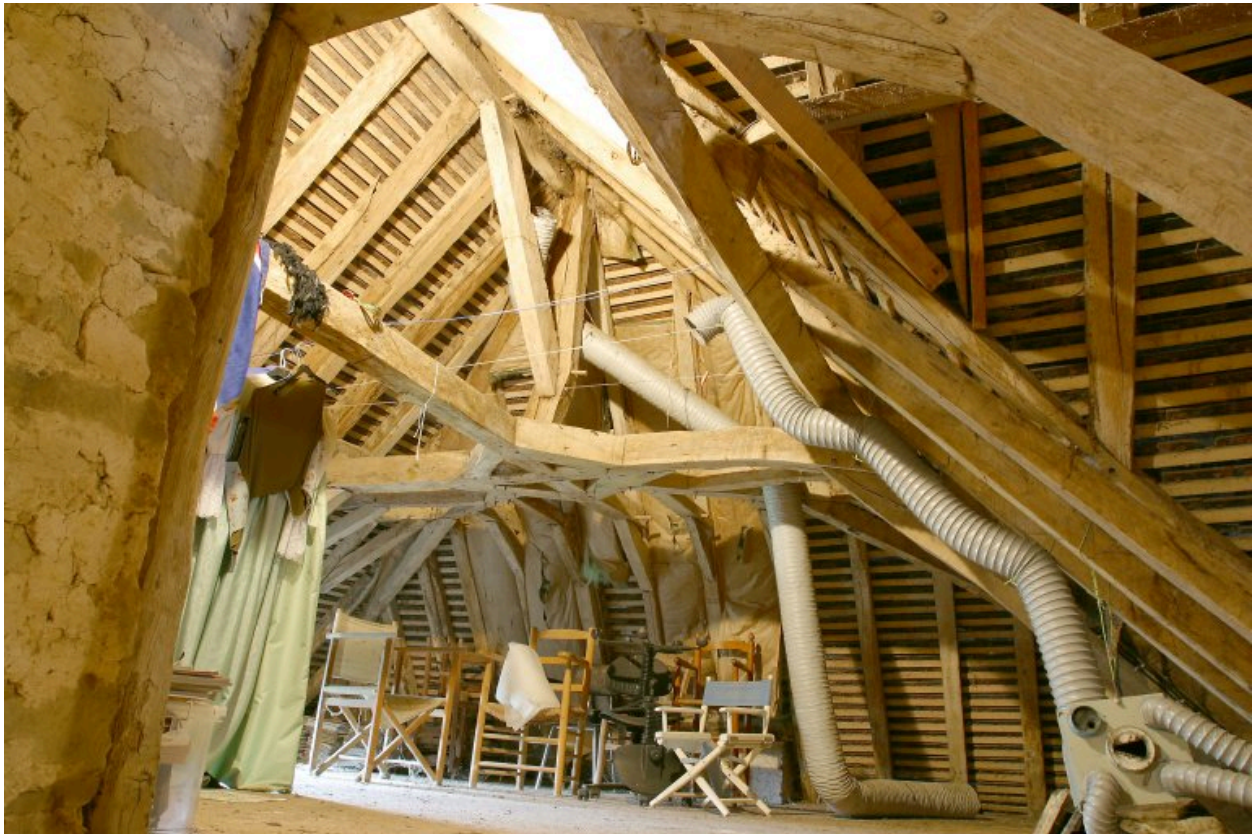
La charpente de l'extrémité nord-ouest du corps de bâtiment sud-ouest.
