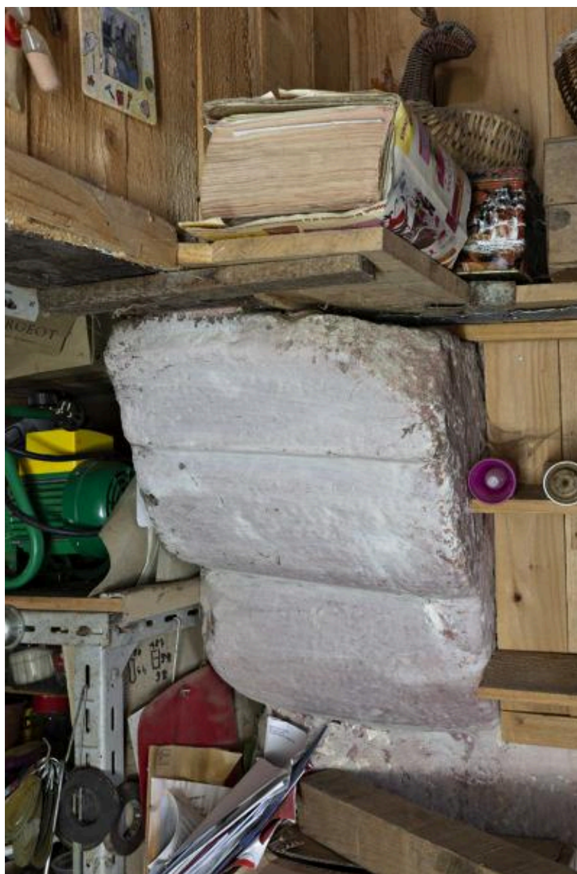
Cheminée de l'ancienne maison, corbeau droit.
