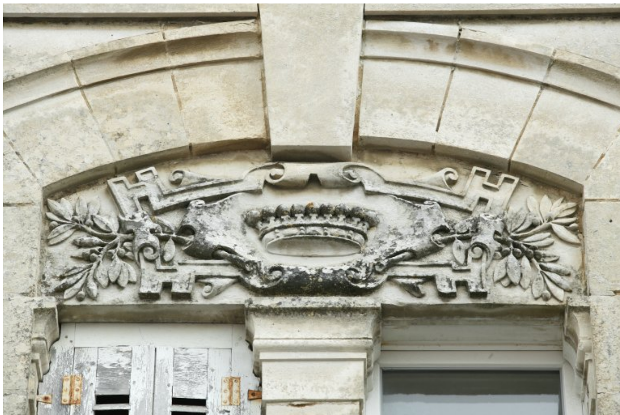
Façade rue Alexis-Vinçonneau : motif avec couronne comtale, sur la fenêtre surmontant la porte d'entrée.
