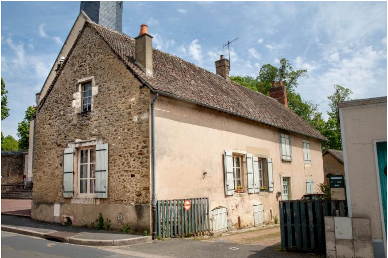
La maison attachée à la minoterie.
