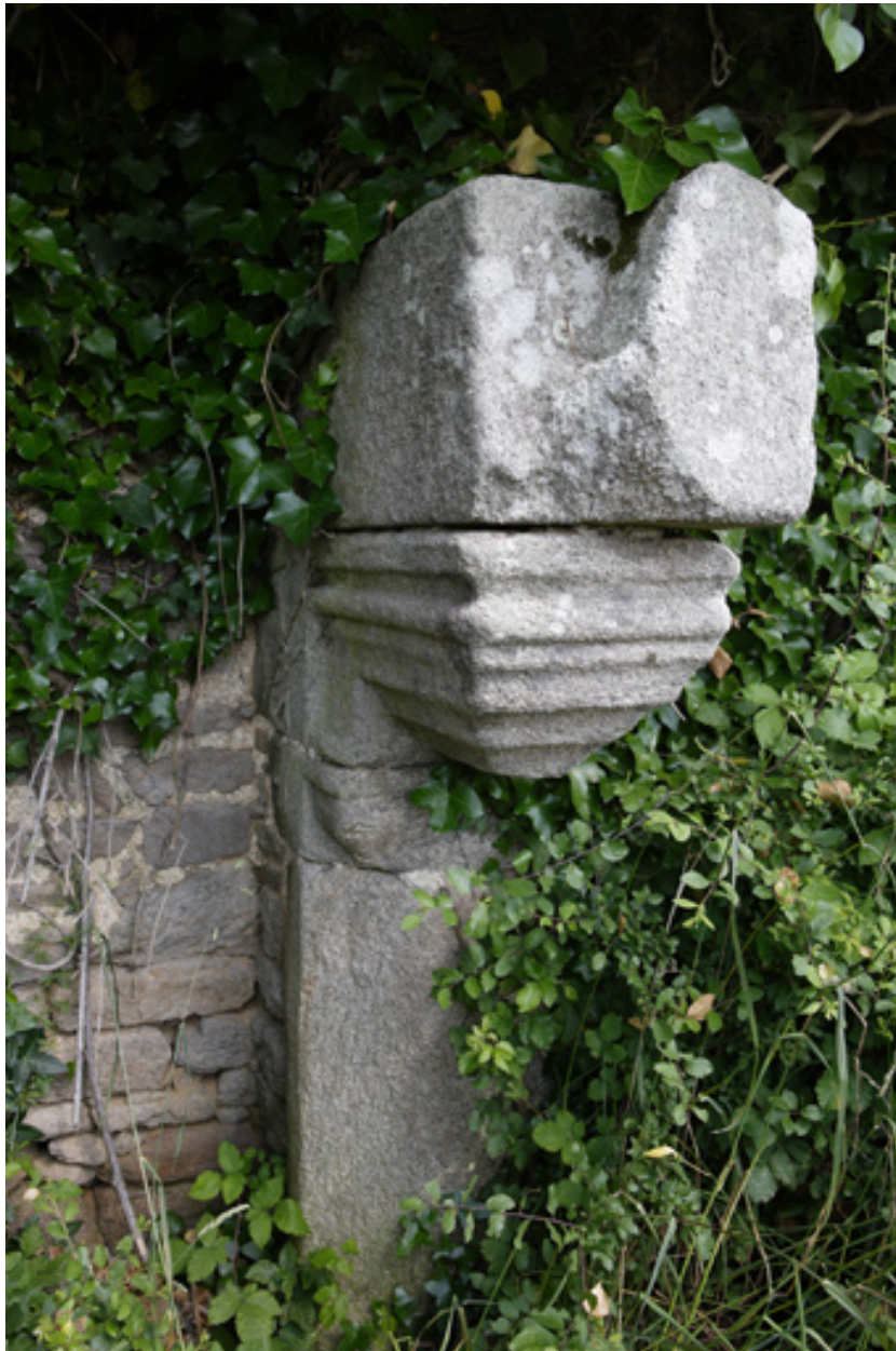
Bâtiment ouest. Logis noble (?). Détail de la console de droite de la cheminée.
