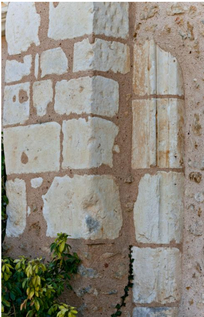
Nef, façade nord : contrefort et vestiges d'une moulure.
