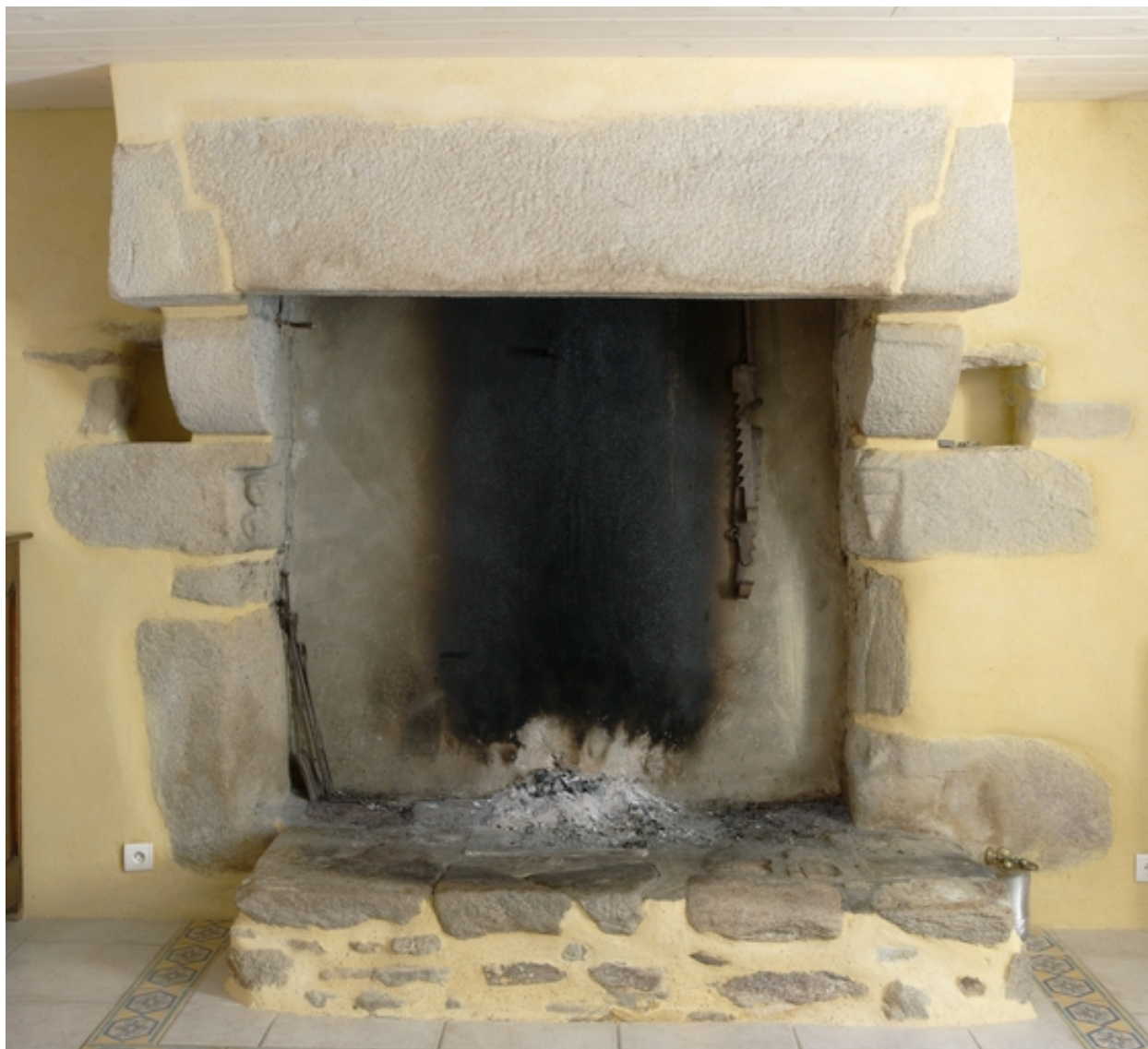
Logis n° 11 rue François-Thuard. Rez-de-chaussée. Cheminée.
