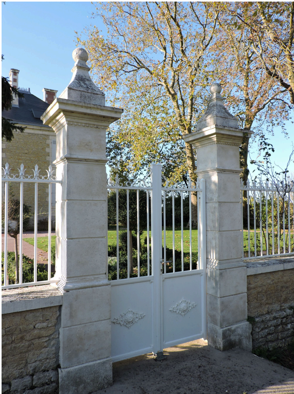
La porte piétonne et ses piliers maçonnés.
